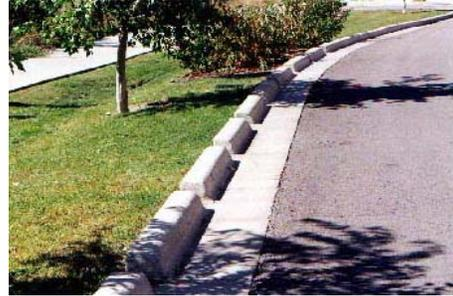
**Figura 20:** Soleras discontinuas y drenaje mediante una pequeña zanja en el bandejón.
