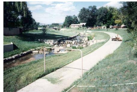
**Figura 34:** Canal de drenaje de aguas lluvias con protección de erosión para flujos más habituales.
