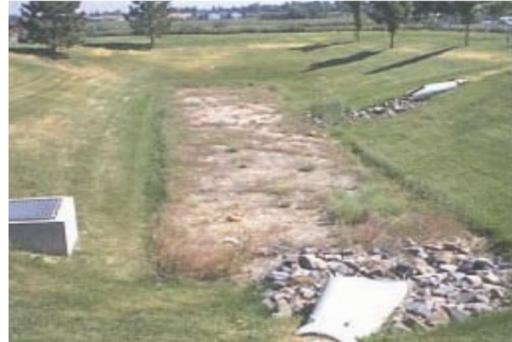
*Figura 11: Zanja de infiltración en construcción.*
