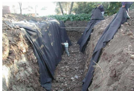
**Figura 12:** Pozo de infiltración semiprofundo.
