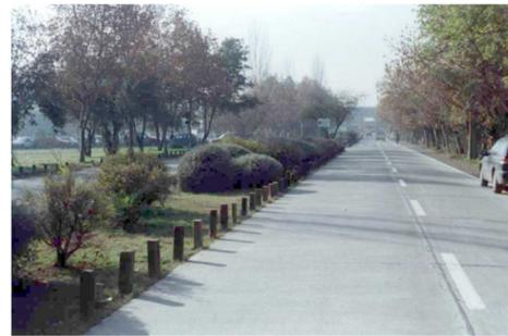
**Figura 21:** Bandejón central rebajado con capacidad de drenaje
