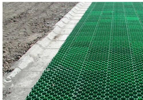
*Figura 9: Pavimentos permeables.*
